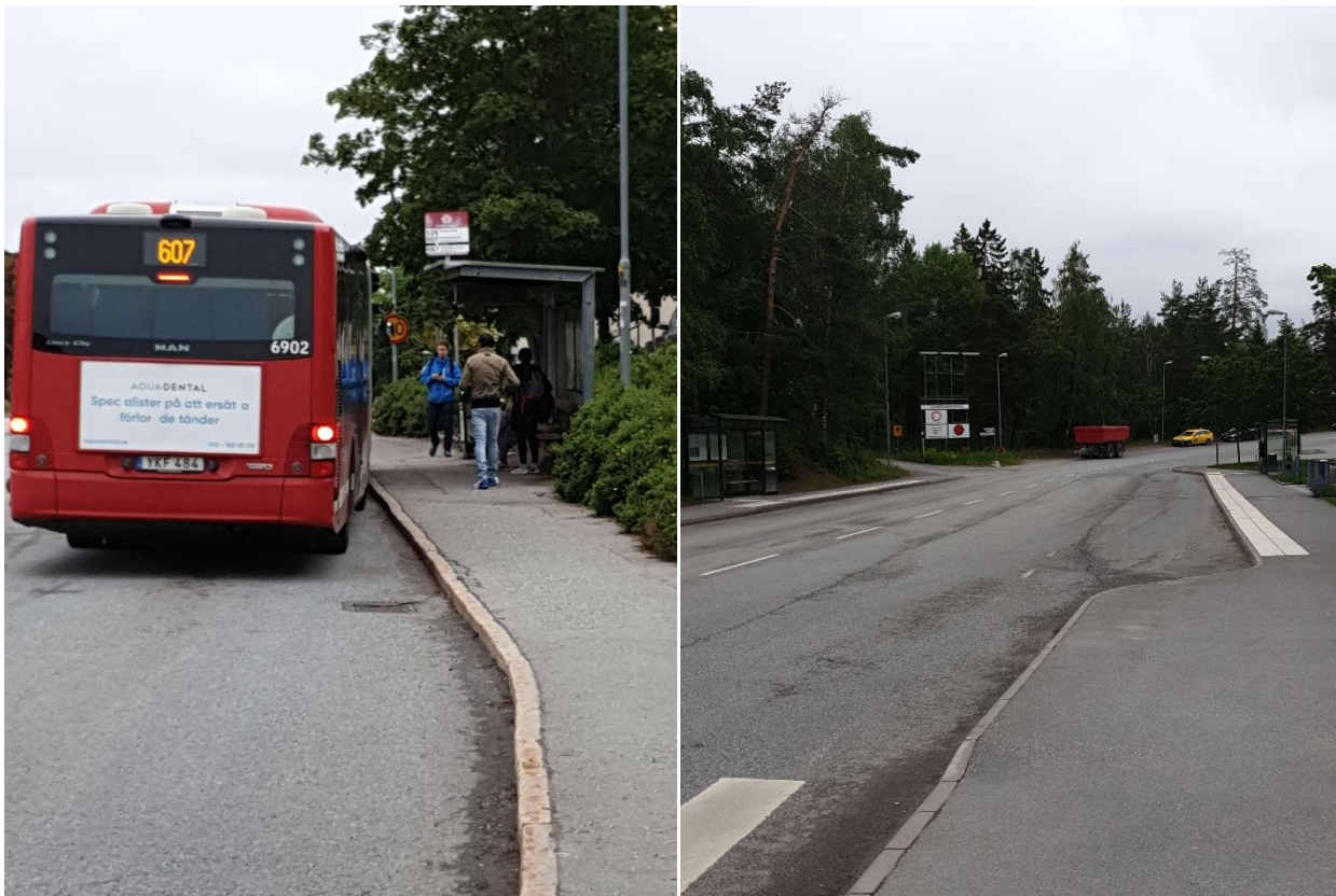
Figur 12. Två busshållplatser på Ribbings väg. Ej tillgänglighetsanpassad till vänster, tillgänglighetsanpassad till höger.
