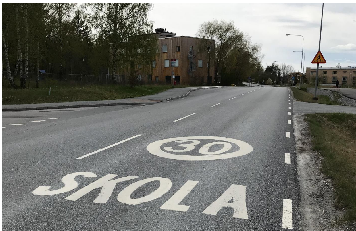
Figur 16. Vägmarkering med information om skola och hastighetsbegränsning på Bollstanäsvägen
