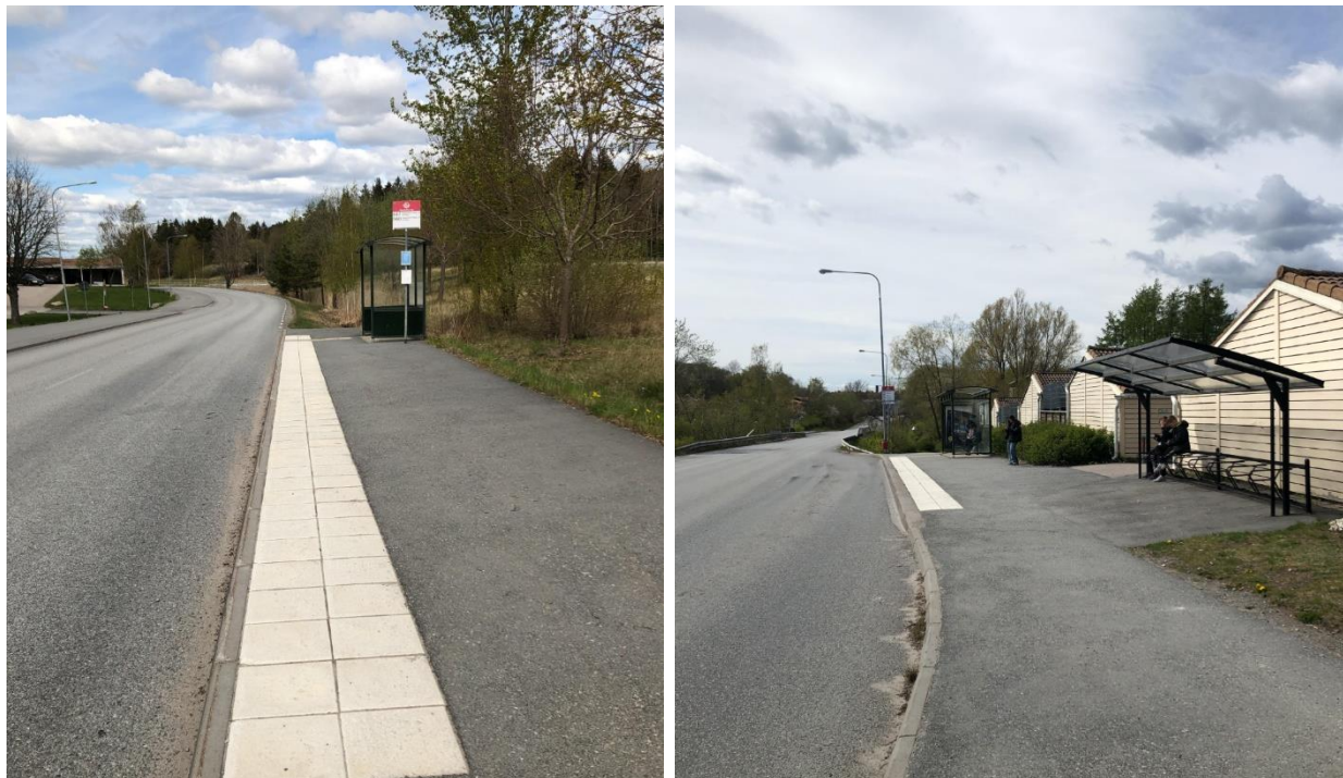
Figur 21. Tillgänglighetsanpassade busshållplatser på Bergkällavägen (till vänster) och på Bollstanäsvägen (till höger)
