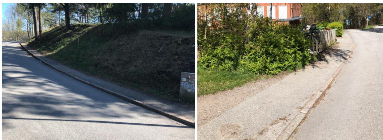
Figur 17. Smal gångbana/trottoar på Staffans väg och Antunavägen i närheten av Rälsens skola
