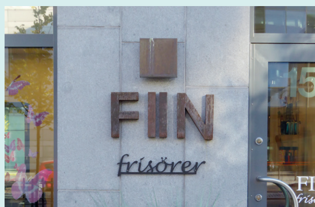
Fasadskylt belyst med separat armatur
