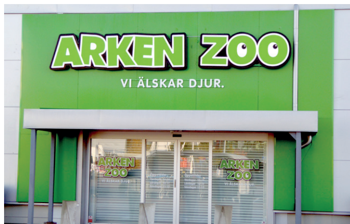
Markerad entré där skylt och fasadkulör samspelar
